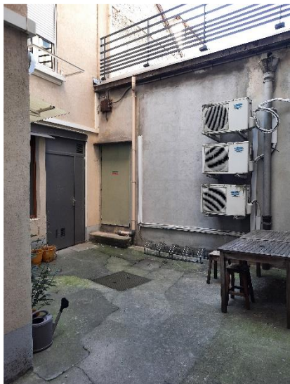
Figure 10 : Accès par cour commune
