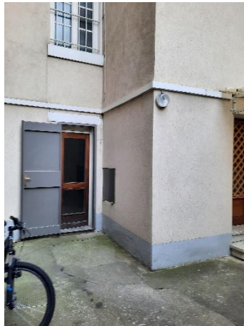
Figure 7 : Entrée du local 1 par la cour commune
