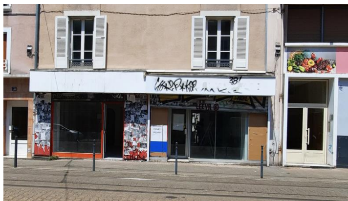
Figure 4 : Entrées immeubles du 134 et 132 cours Berriat à Grenoble
