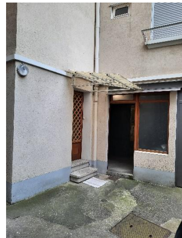
Figure 6 : Entrée du local 2 par la cour commune
